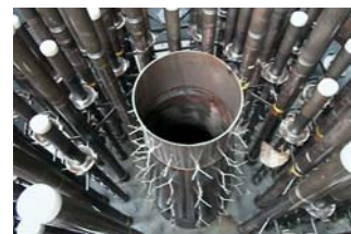
ANSCHWEIßANKER FÜR AUSMAUERUNG
